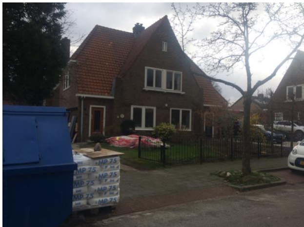
Het Goede Woonhuys: De renovatie is gestart
